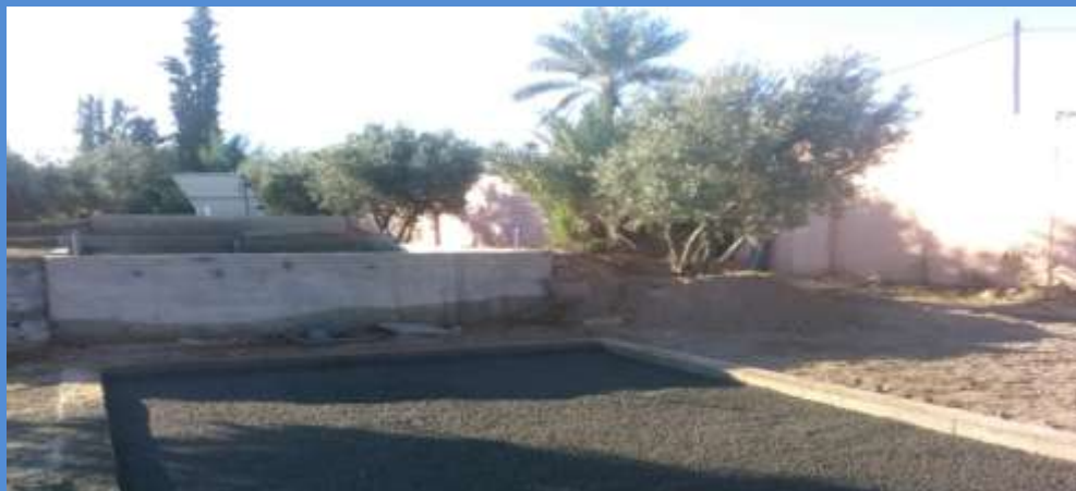
Projet Ecologique de Traitement et de Réutilisation des Eaux usées
